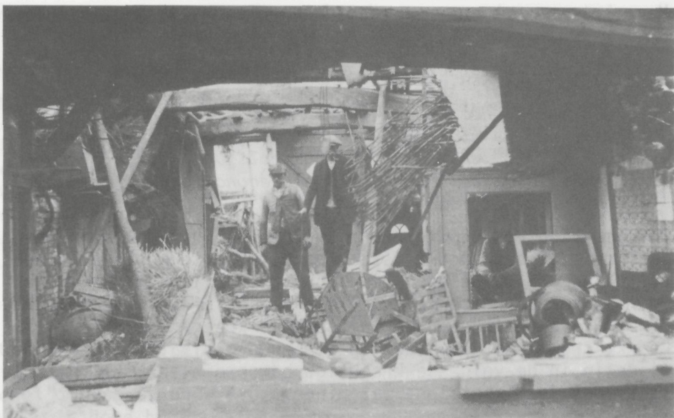
Interieur van de verwoeste boerderij "Frankbaas". Hier is nog een stuk "wand" te zien (vlechtwerk van hout, bestreken met leem). V.l.n.r.: eigenaar Jans Luttikholt, Gert Colenbrander, en in de bedstee: Jans Mentink.
