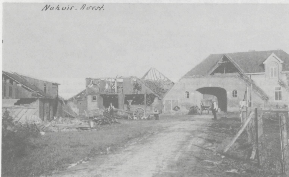
Boerderij Nahuis in Avest heeft schijnbaar aan de rand van de cycloon geleden. Het woongedeelte bleef vrijwel intact. V.l.n.r.: Willem Smeenk, Hendrik Baak (Hiddink), beiden knechts, Hendrik Nahuis, eigenaar.
