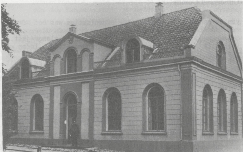
Het oude gemeentehuis van Eibergen: zetel van de "Finantieele Centrale Eibergen" en van het bureau gemeentewerken, voor de gelegenheid omgedoopt tot "plaatselijk bouw bureau".
